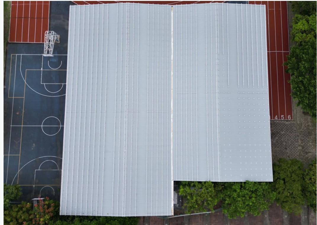
屋頂浪板與 支架建置
