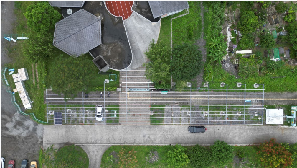
基礎結構建置
