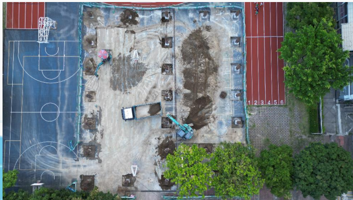
基礎結構建置
